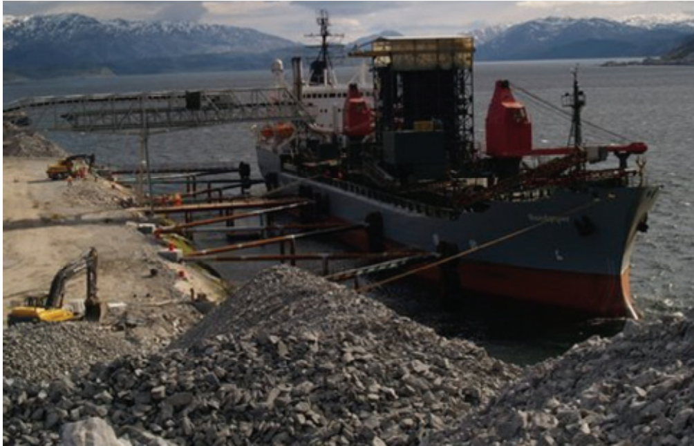
Figur 5-9: Steinleggingsfartøy ved Aqua Rock anlegget på Strendene.
