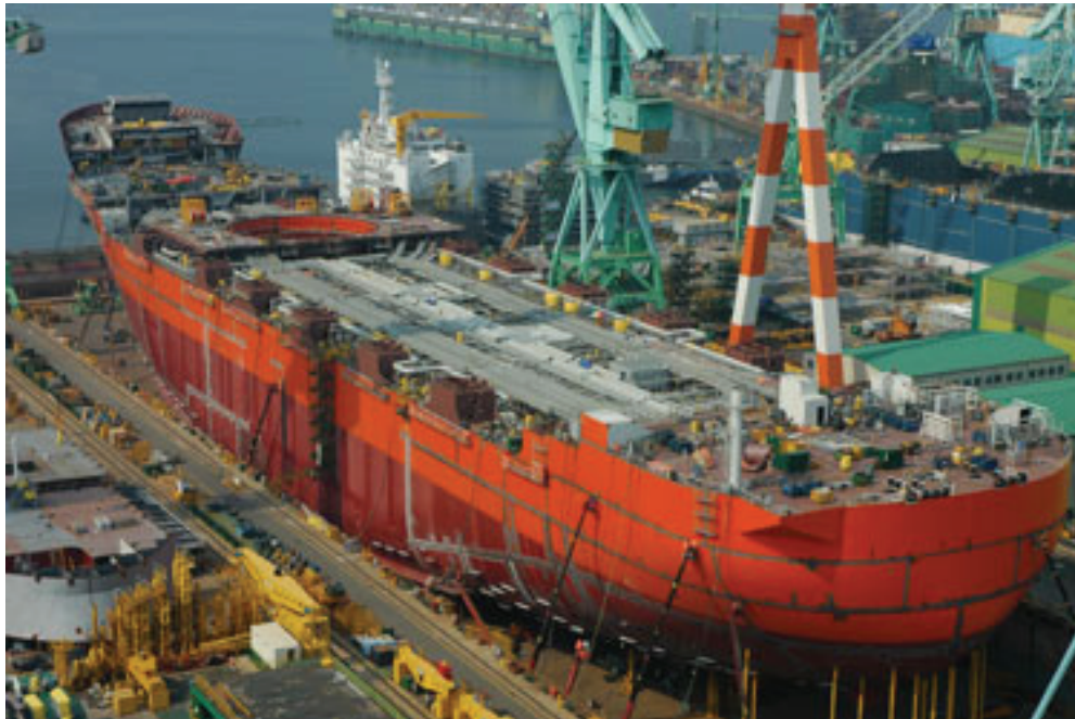
Figur 5-5: Bilde fra byggingen av Skarv-skipet.
