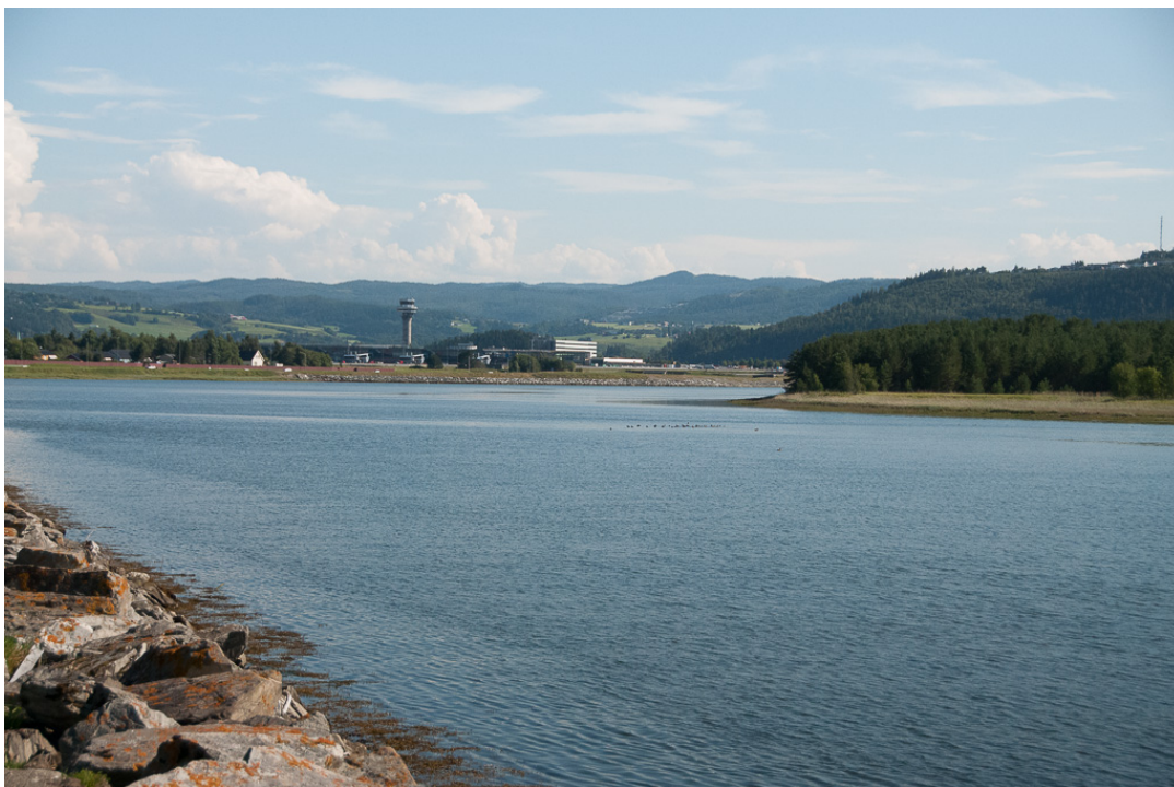
Figur 4.2. Foto av Halsøen tatt fra Tangen omtrent der det er vurdert å bygge gangbru over til Langøra Nord, som vi ser deler av til høyre i bildet. Det er flo sjø, og bildet viser at steinfyllinga går helt ned i sjøen. Foto: Magne Husby
