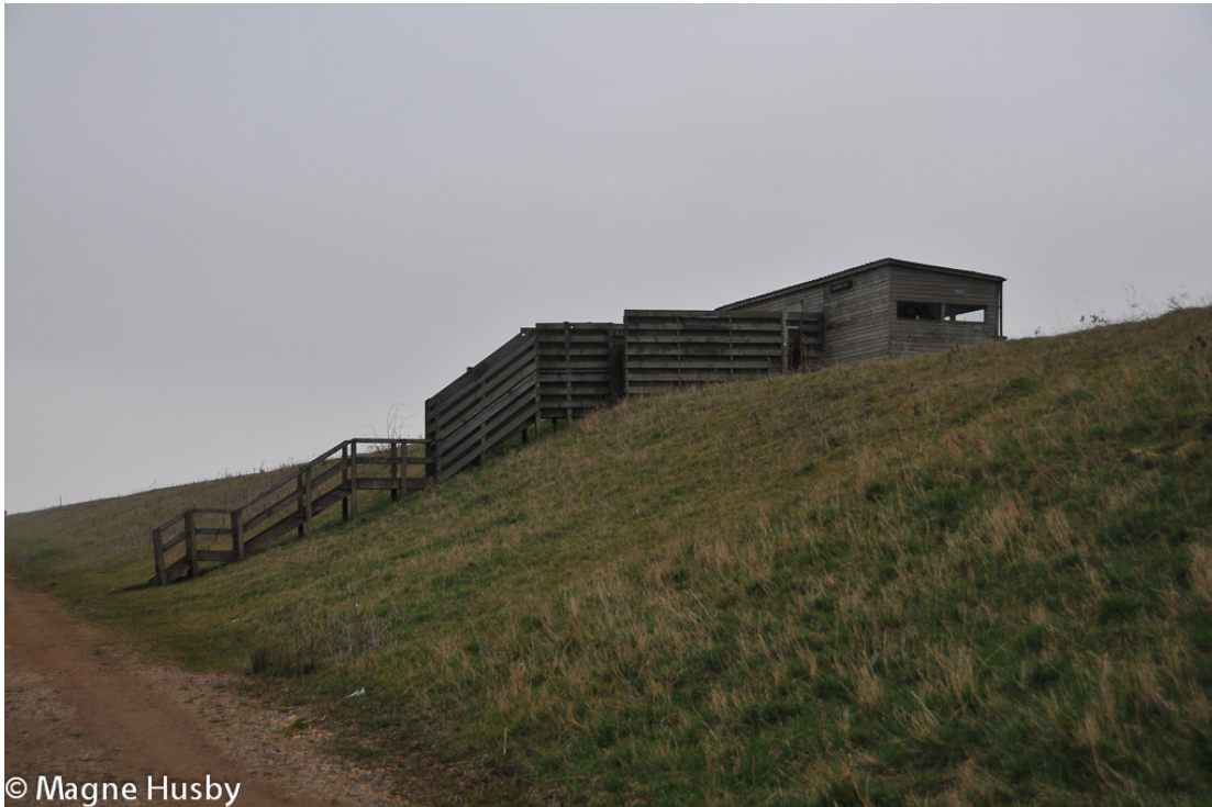
© Magne Husby Figur 4.1. Skjul for fuglekikking i et av RSPB sine områder i England. Legg merke til at adkomsten til tårnet er skjermet langt ned i bakken før fuglene i våtmarksområdet bak jordvollen vil oppdage dem. Legg også merke til de smale gluggene som gjør at fuglekikkeren er forholdsvis skjult, samt at bakveggen er hel og høy nok til at menneskene i skjulet aldri viser sin silhuett til fuglene.
