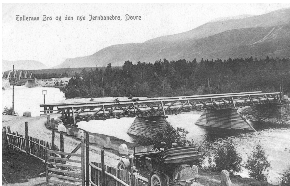
Bil og jernbane i møte på Dovre. Opprinnelig var delingspunktet for Rauma- og Dovrebanen lagt til Tallerås bro mellom Brennhaug og Dovre kirke, men ble flyttet lenger nord til Dombås (Østvedt (1954), postkort i egen samling).
