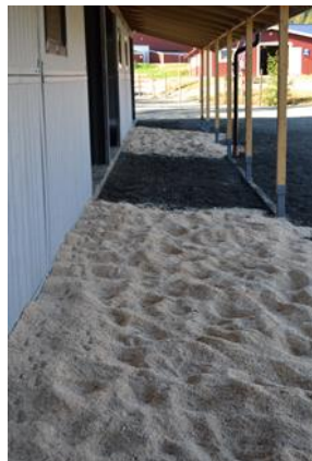
Figur 7, Området utenfor liggehallen som på plantegningen er toalett
