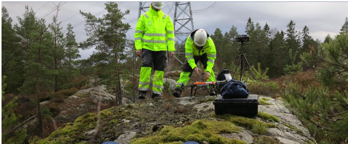
Bilde 12: Drone klargjøres før inspeksjon.
