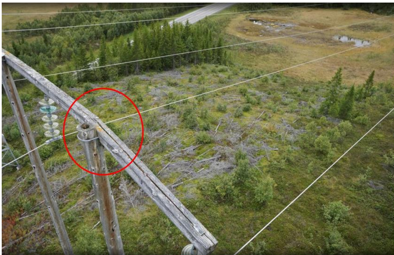
Bilde 8: Innledende brudd i travers på det punkt der traversen har høyest bøyemoment.
