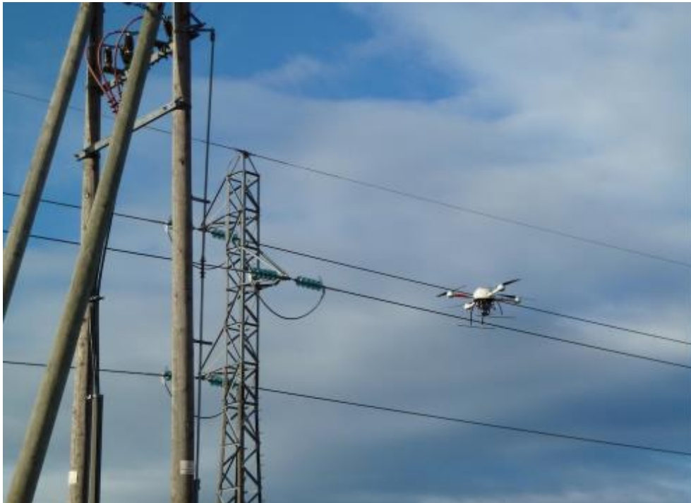
Bilde 4: Droneinspeksjon. Med tillatelse fra Møre UAS
