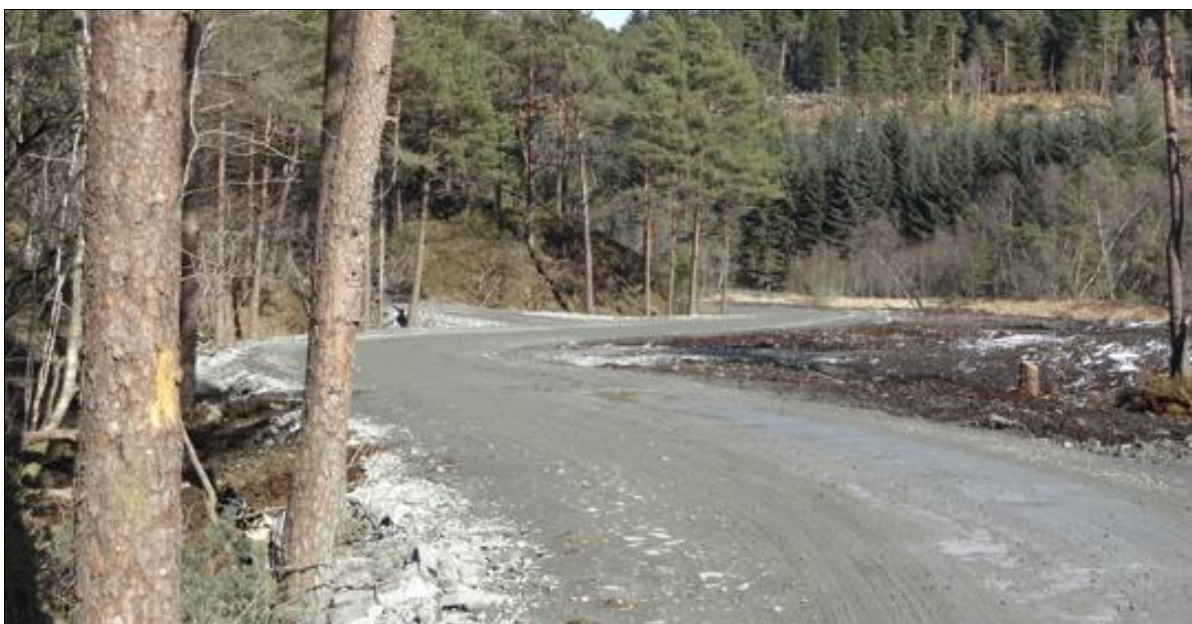
Nybygget skogsbilveg (2013) med fin miljøtilpasset linjeføring i Fana ved Bergen. Foto: Helge Kårstad. Kystskogbruket.
