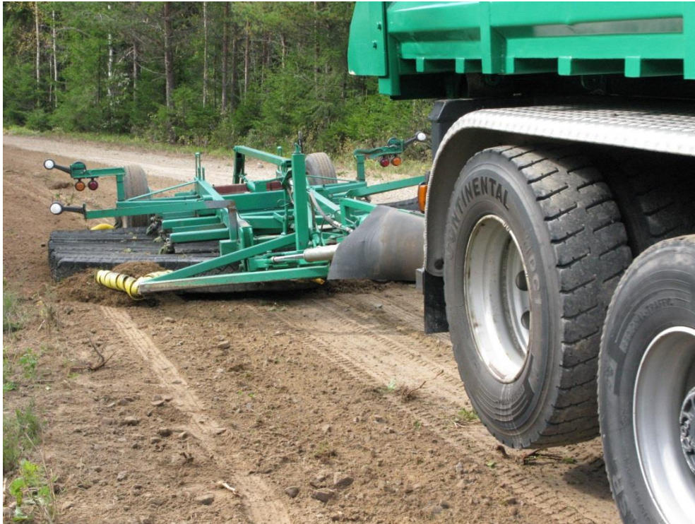
Fint arbeid gjort med vegskrape trukket av en lastebil. Det er skrapet helt ut til grøftkanten. Foto:AK
