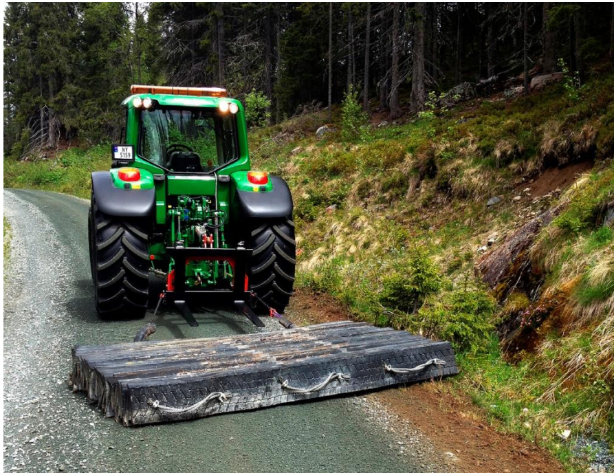
Her er Drammenslådden brukt til veivedlikehold. Resultatet ble veldig bra og det er enkelt å justere tilkoblingen så slådden også får bort graskanten. Foto: Gummi-industri. AS
