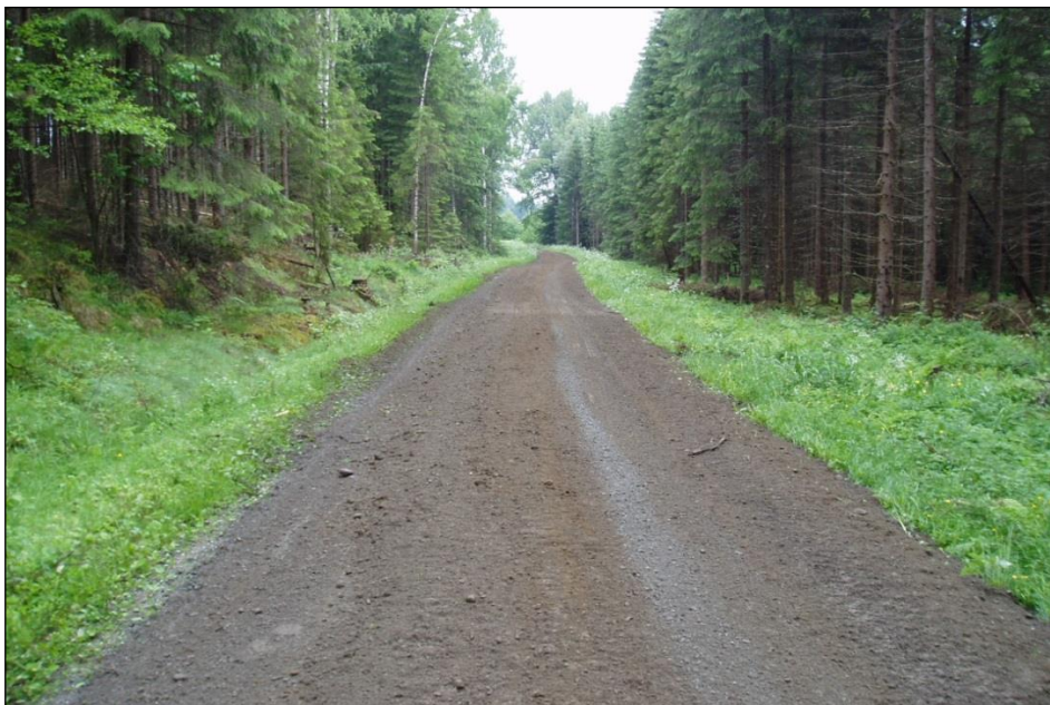
Denne vegen er gruset og skrapet slik at den har bra kuv og vannet kan renne av. Trær i grøfta er fjernet. Foto: Leif Kjøstelsen. Skog og landskap
