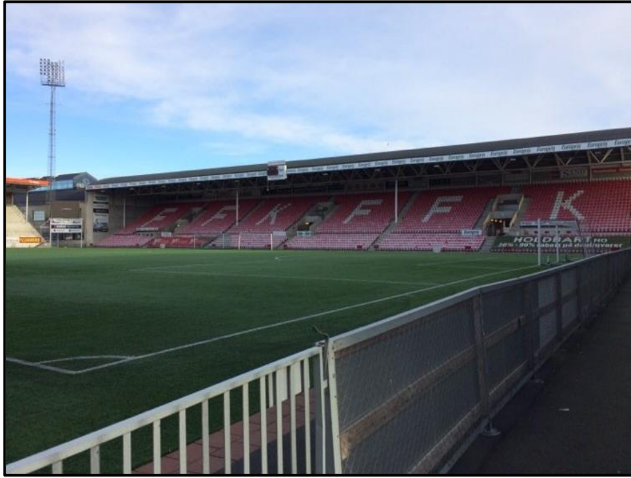
Figur 3.2 Nye Fredrikstad stadion er bygd mellom to gamle verkstedhaller fra FMV. Foto: Mats Eid Bjørset
