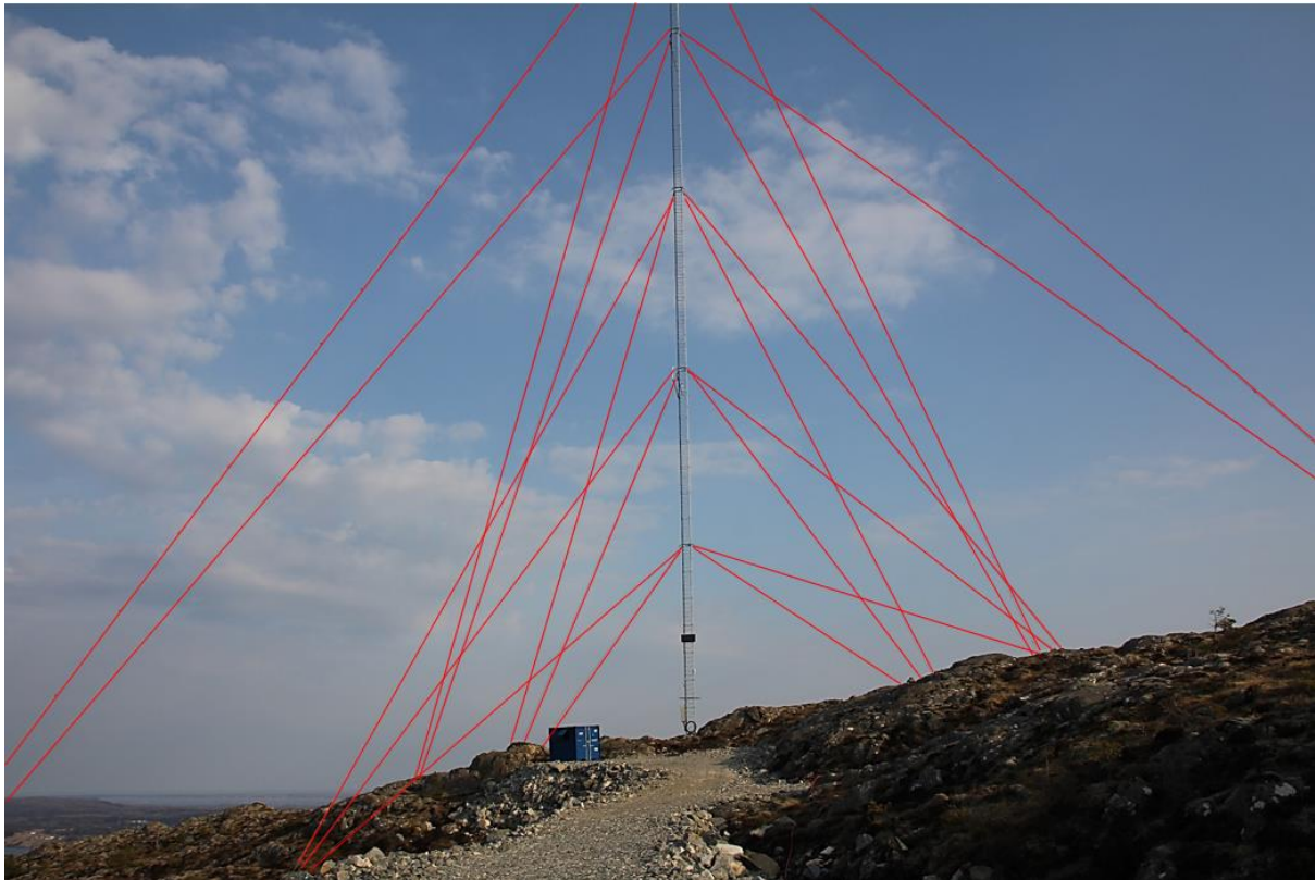
Bilde 4.2. Eksempelbilde av vindmåler fra Hitra med et nettverk av barduner i metall. Bardunene er her gjort mer synlig med rød farge, men normalt er det tynne metallvaiere som kan være vanskelig for fugl i stor fart å oppdage. Foto: Martin Pearson.
