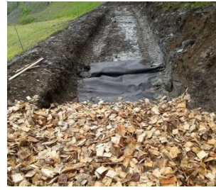
Bilde 11 Plassering av fiberduk og flis
