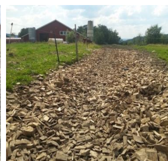
Bilde 4 Anlagt drivgang
