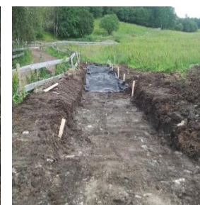
Bilde 8 Anlagt drivgang
