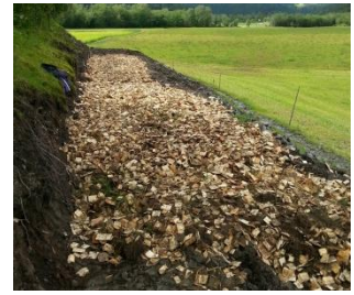
Bilde 12 Anlagt drivgang
