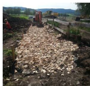
Bilde 7 Plassering av fiberduk og flis
