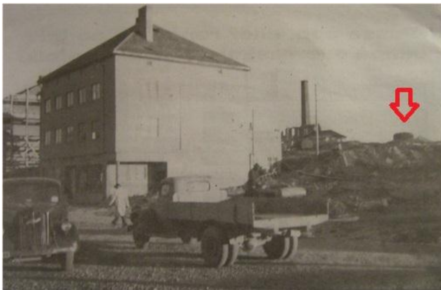
Figur 19: Panserkuppel fra anlegg 20b, ca. 1950. Kilde: thomaslillevoll.net
