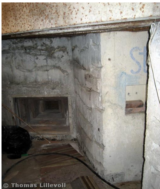
Figur 14: Inngangsparti anlegg 15 i 2014. Kilde: thomaslillevoll.net
