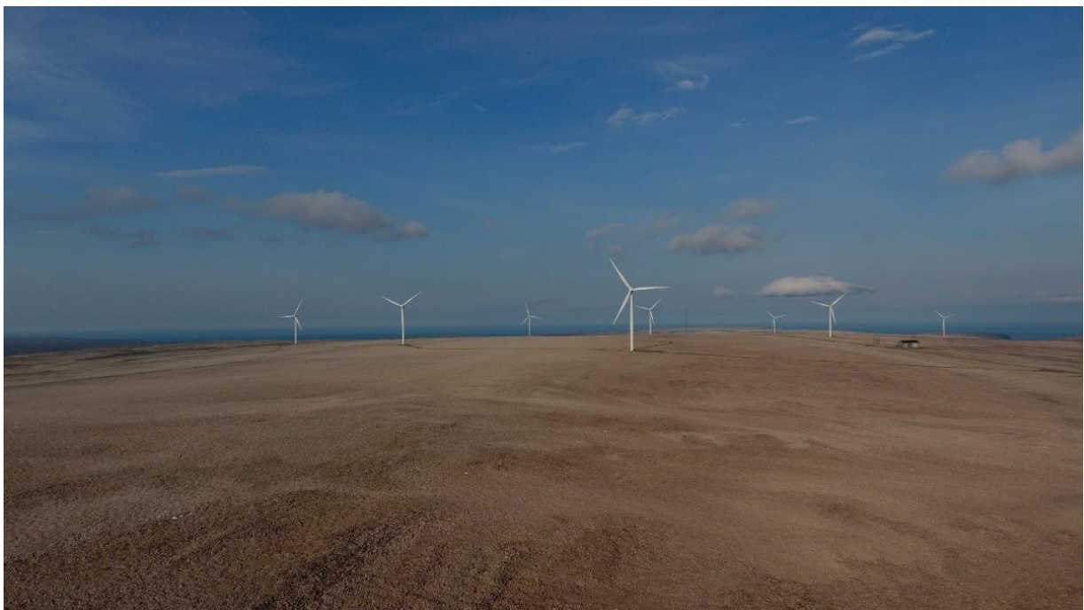
Figur 6: Raggovidda vindmøllepark Foto: Øyvind Friskilä
