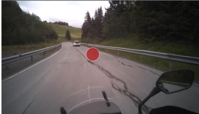
Figur 10: Spor i veien (Amundsdalvegen) (Veistrekning 2 med svinger, Gruppe (1,) Fører 3).
