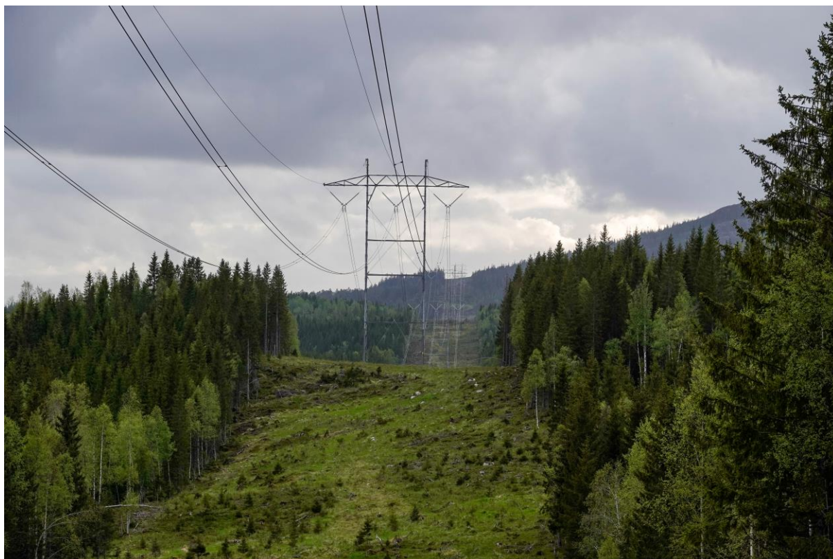
Bilde 2. 420 kV kraftlinje øst i undersøkelsesområdet, se Figur 1.1, fotografert 31.5 2023.
