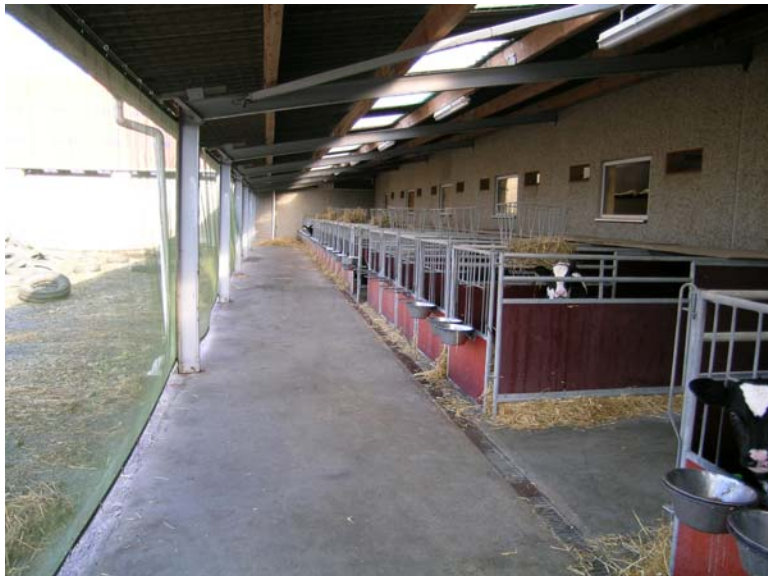
Figur 1 Store enkeltbokse placeret langs staldens yderside, hvor et stikspær giver overdækning. Bemærk pladen over boksenes bagerste halvdel, som skaber to klimazoner i boksene.
