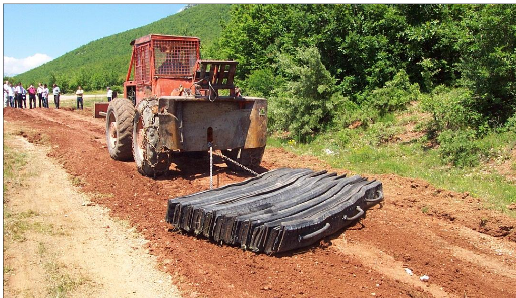
Her er Drammenslådden brukt på en demonstrasjon i Kosova. Resultatet ble veldig bra. Den er her trukket av en gammel rammestyrte traktor, men en vanlig stor jordbrukstraktor er noe enklere å bruke . Foto: AK
