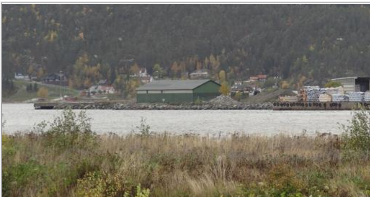
Den kommunale kaia i Namsos (til venstre i bildet) skal nå utbygges for 11 millioner kroner og blir viktig for skogbruk og industriaktører i Trøndelag. Til høyre sagbruket Moelven Van Severen. Foto; Helge Kårstad
