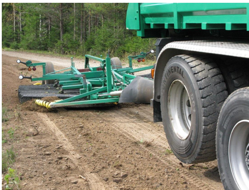
Fint arbeid gjort med vegskrape trukket av en lastebil. Det er skrapet helt ut til grøftkanten. Foto:AK
