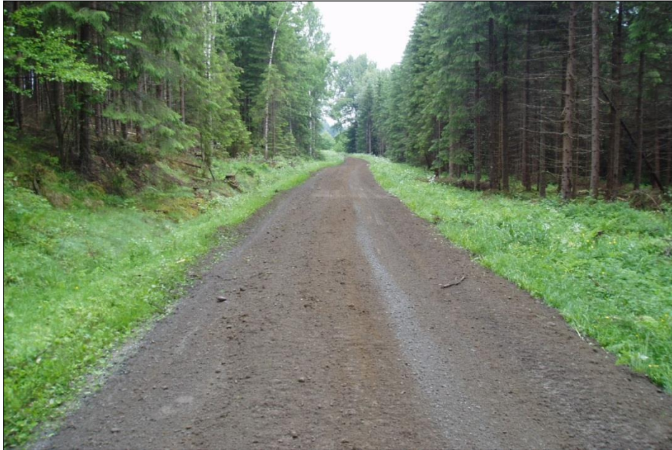
Denne vegen er gruset og skrapet slik at den har bra kuv og vannet kan renne av. Trær i grøfta er fjernet. Foto: Leif Kjøstelsen. Skog og landskap
