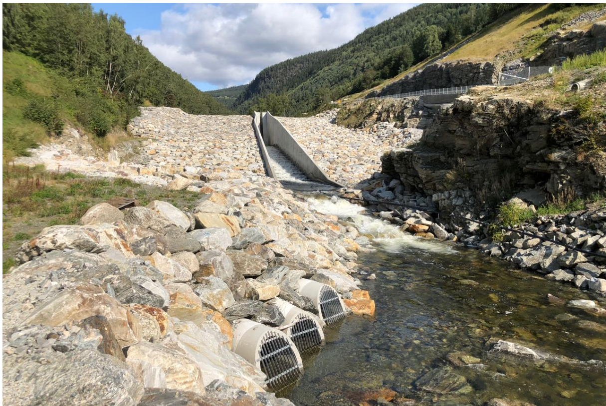
Figur 5: Fagervold bunnlastsperre i Veikleåa, Kvam. Foto: V. Hagen 2018.
