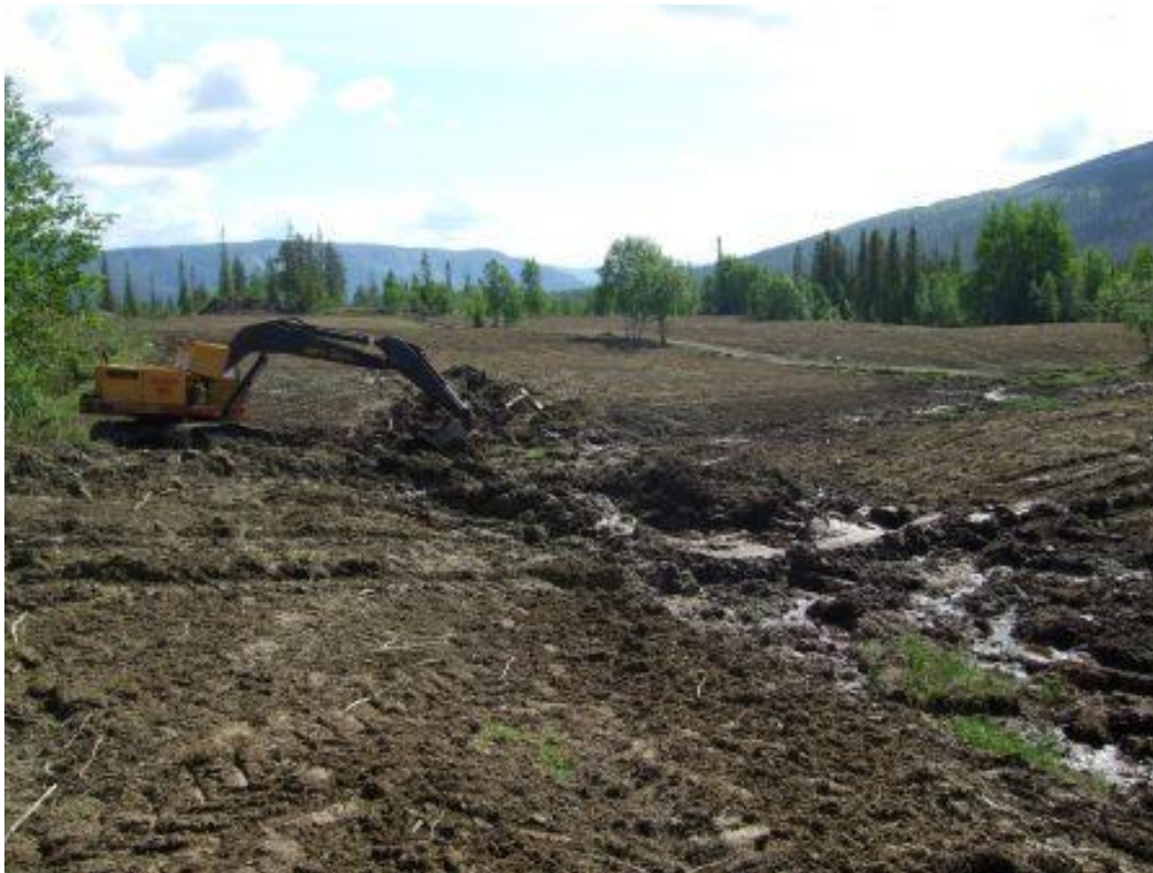
Figur 11. Nydyrking og grøfting (Rana kommune)
